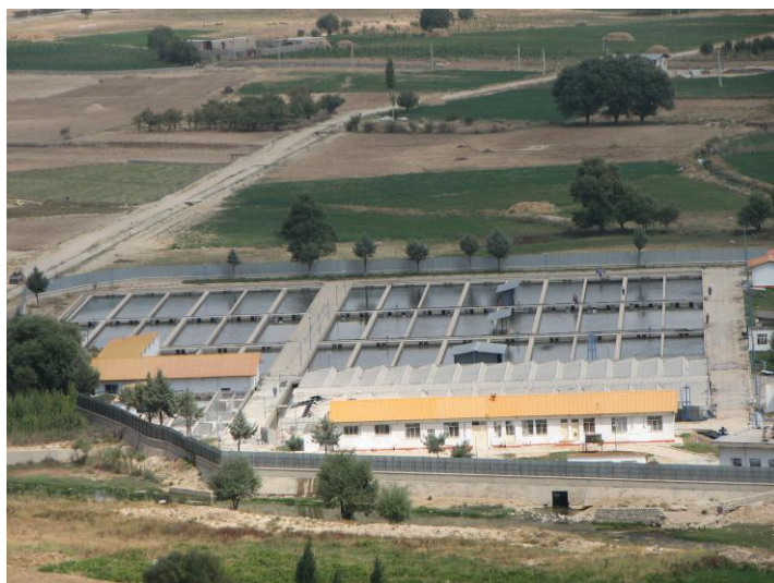
تصویر ۲-۱: نمای محل اجرای پروژه
